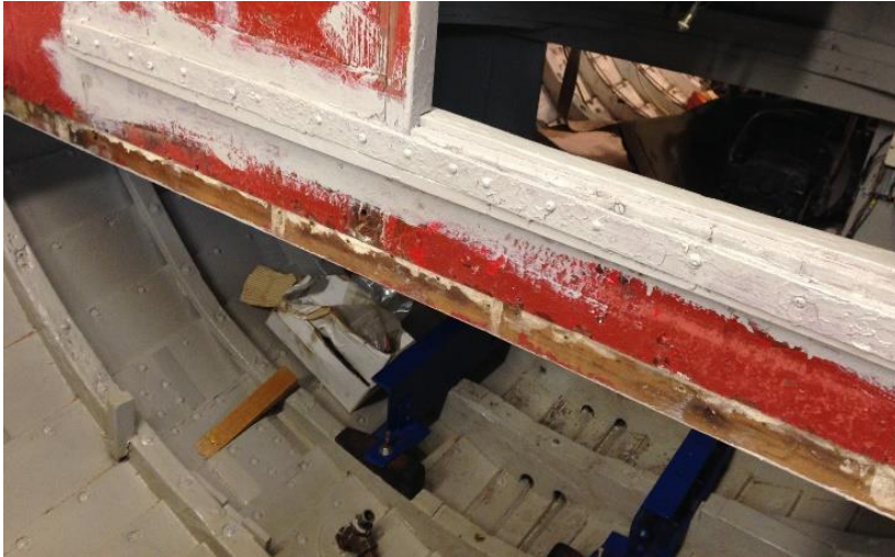
Eljan ÍS 590. Mynd: Byggðasafn Vestfjarða.
